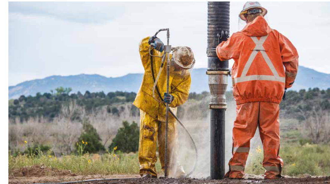
Utilisation typique du véhicule Hydrovac : travail avec de l'eau et un système d'aspiration
